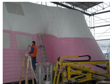
Application sur un support de type mousse polystyrène ou autre
