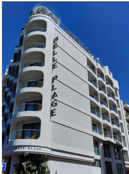
Façade de l'Hôtel Belle Plage à Cannes - Panneaux ondulés imitation enduit frotté - Planet Staff - Cagnes sur Mer - Atelier Jean-Loup Bouvier - Les Angles
